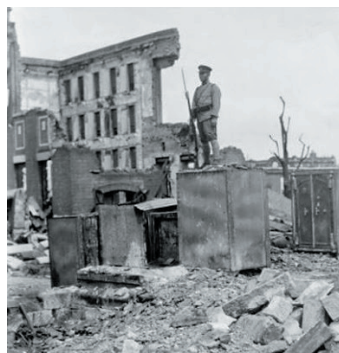
瓦礫となった銀行の金庫の上 で兵隊が見張る。(報道写真)
