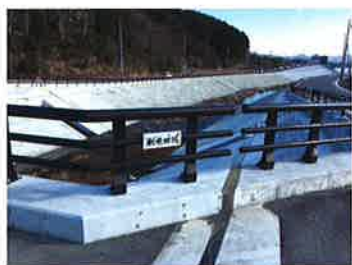
コンクリートで固められた新井田川かさ上げ地（2019年3月撮影）
