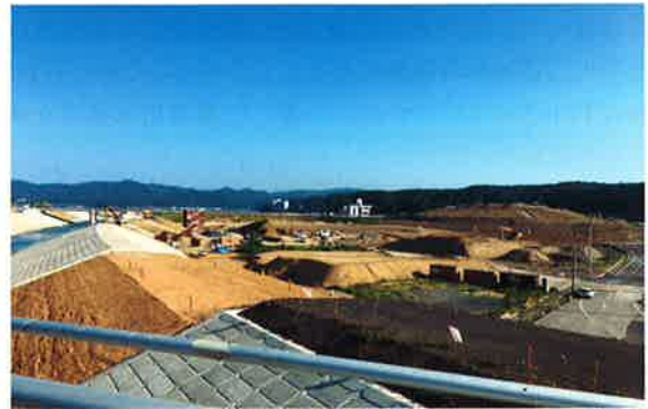
南三陸町の八幡橋から、かさ上げ地を望む。中央左の赤茶の構造物が、被災した3階建ての防災対策庁舎
