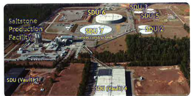
米国サバンナリバー核施設での汚染水モルタル固化の様子（「SRS Liquid Waste Planning Process Rev.21 (Jan.2019)」より）
