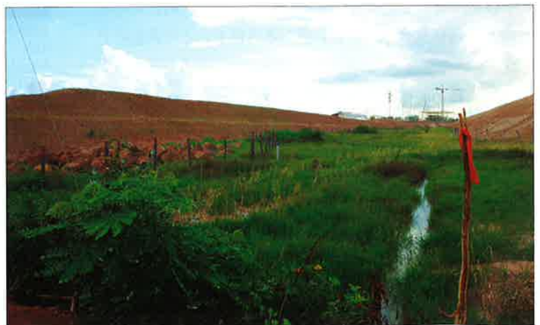
用水路を遮断する形で製糖工場の建設が行われている
