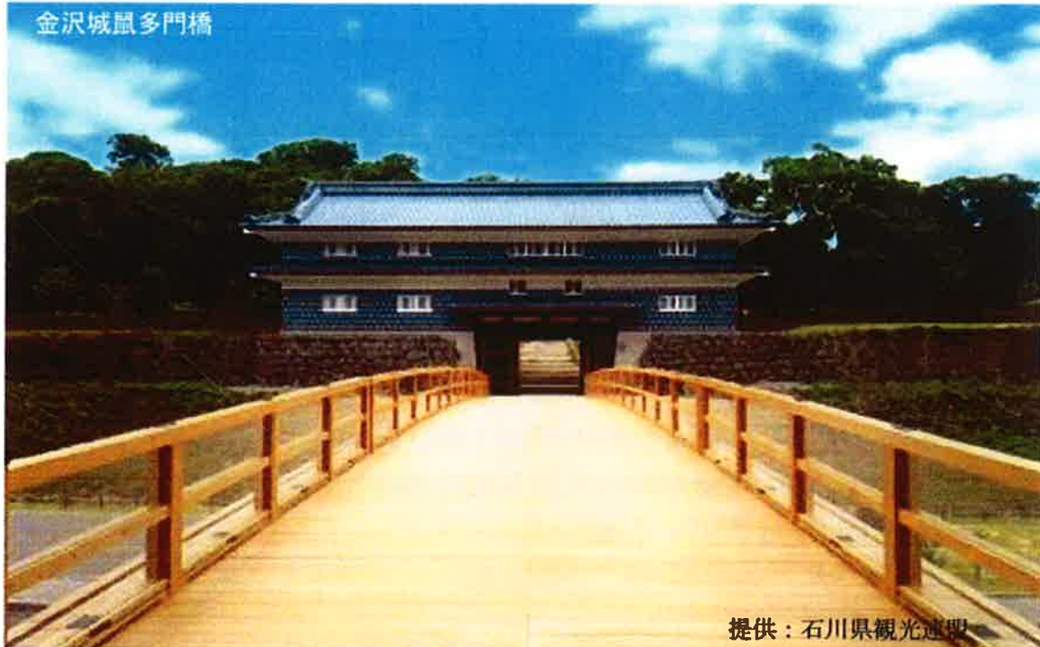
加賀藩前田家の居城、金沢城の西側の門を復元整備
