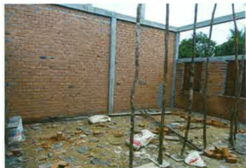
急ピッチで工事が進んでいる
