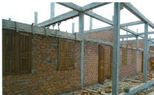
校舎はレンガ造りの平屋建て
