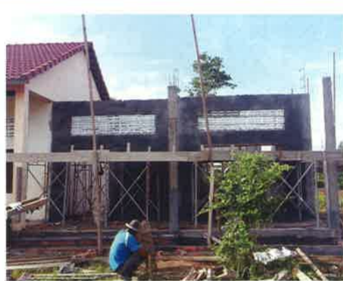
建設工事の様子
