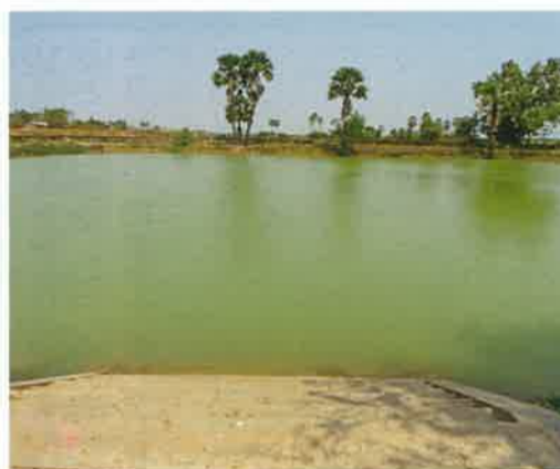
修復が終わり、満水になった池
