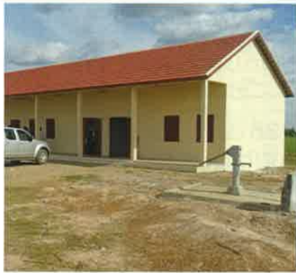
ほぼ完成した小学校の校舎
