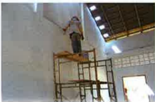
工事中のジーポア小学校校舎
